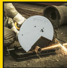
9 Corte de barras de refuerzo, vigas de acero
